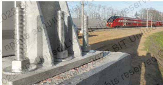
Монтаж стоек шумозащитных экранов IV главного пути Киевского направления (ОАО «РЖД», г. Москва, 2019 г.)
