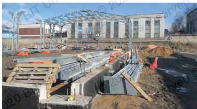
Крепление каркаса быстровозводимого здания к стандартным фундаментным бетонным блокам: шпилька М20, глубина заделки L=300 мм (складской комплекс, Ленинградская область, Гатчинский район, 2011 г.)
