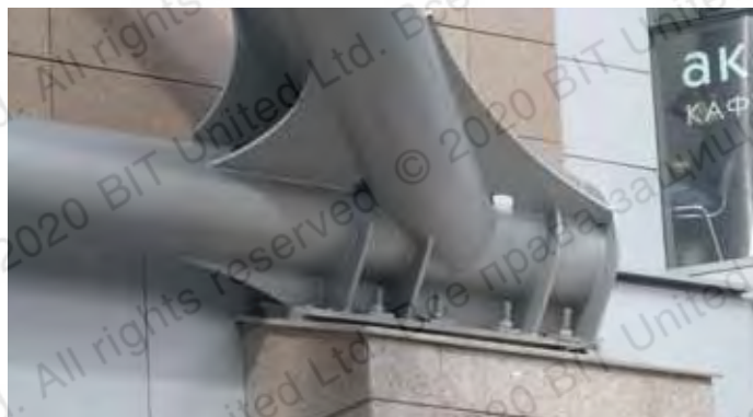
Узел крепления пространственной конструкции к пилястрам (минимальное расстояние от края и между осями анкеров)
