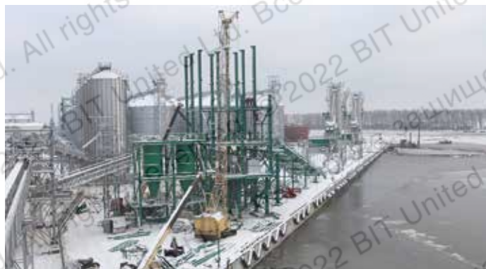
Монтаж металлоконструкций, силосов и элеваторов в зимний период (маслоэкстракционный завод «Союзнефтегаз», Калининградская область, г. Светлый, 2012 г.)
