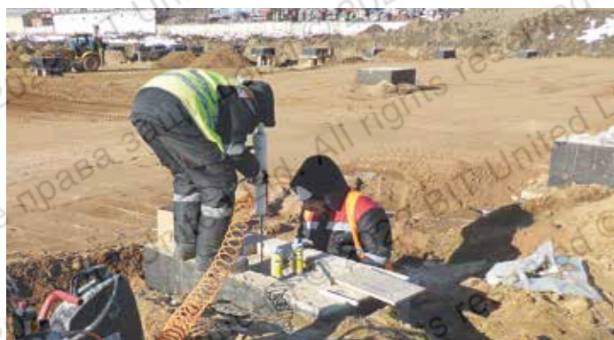
Инъектирование химического состава с применением пневматического оборудования для установки анкеров (Автосборочное производство Hino Motors Ltd, г. Химки, 2019 г.)
